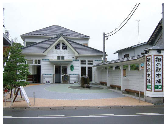
旧喜連川警察署を改修した「街の駅本陣」
